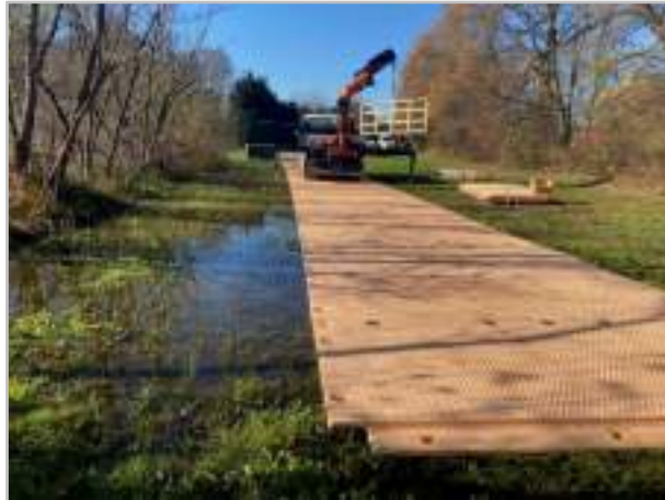
Photo 4 : Exemple de plaques pour la circulation des engins
