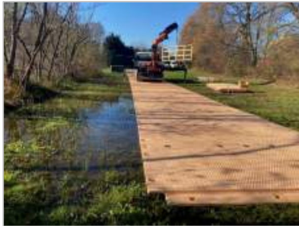
Photo 147 : Exemple de plaques pour la circulation des engins
