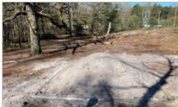
Figure 9 : Réalisation de merlons en faveur des hyménoptères. Zone Natura 2000. Travaux réalisés à l'automne 2022.
